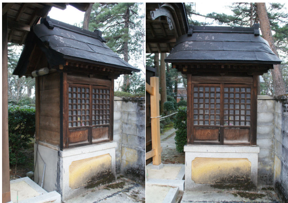
修復前「地藏堂」
