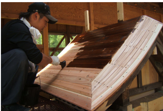
塗装（建築大工コース）
