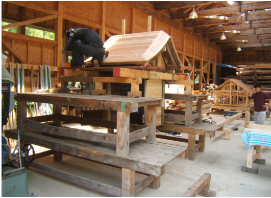
屋根野地板張り（建築大工コース）
