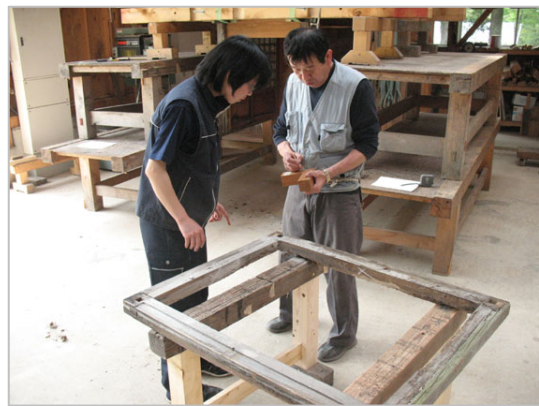
土台解体（建築大工コース）
