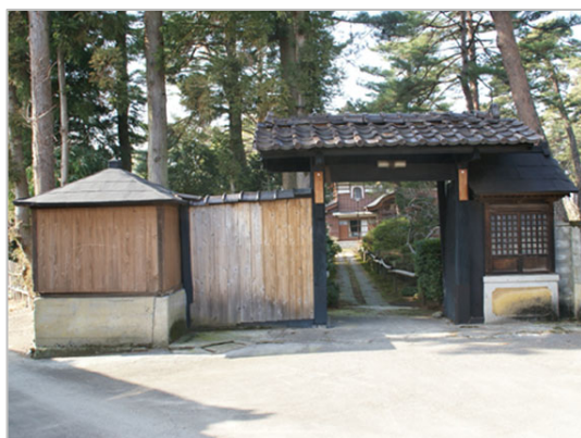
解体修復前「表門」
