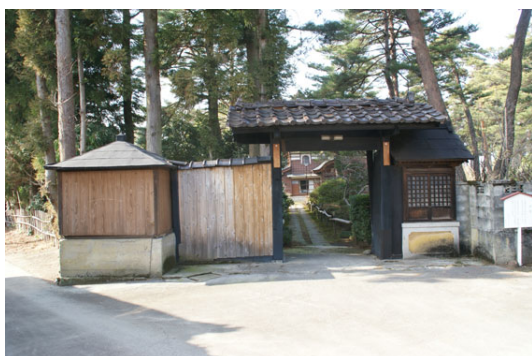
解体修復前「表門」
