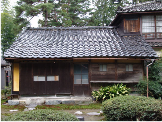
解体前「茶室棟」
