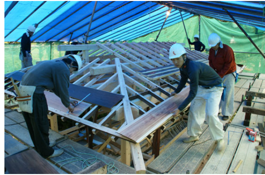
化粧屋根組立て（化粧裏板張り）
