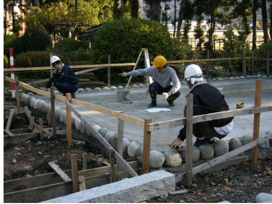
布基礎墨打ち（建築大工コース）
