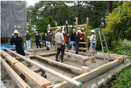
軸部組立て（建方）：建築大工コース
