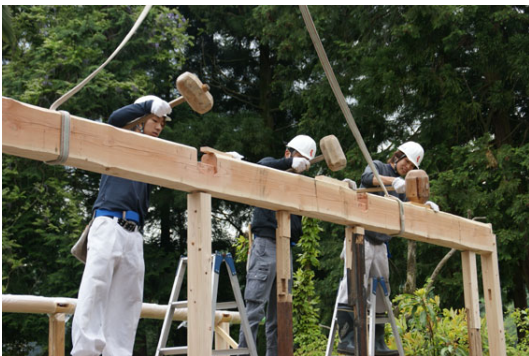
軸部組立て（建方）：建築大工コース
