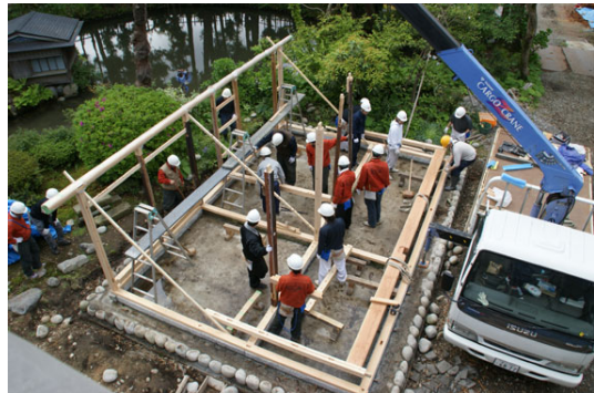
布基礎墨打ち（建築大工コース）
