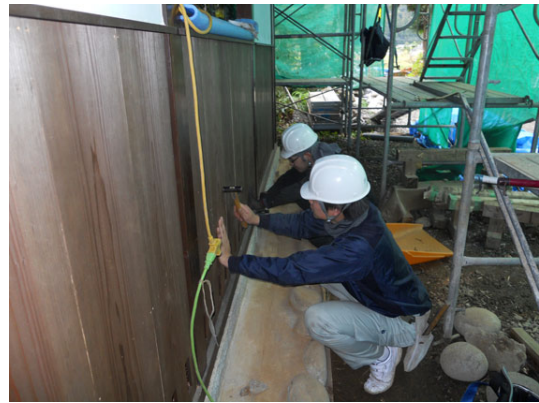
外部腰板張り
