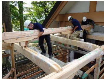
「鶴坂神社吊殿」改築（富山市）：伝統的木組み構法による木造建築
