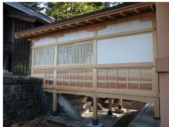
「鶴坂神社吊殿」改築（富山市）：伝統的木組み構法による木造建築
